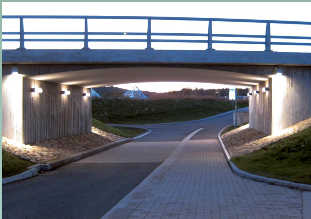
Gång- och cykeltunnel, Björkris, Kungsbacka. Armatur: Marburg och Superlight Compact. Ljusdesign: Jan-Erik Wallerstedt, Belpro Göteborg.
