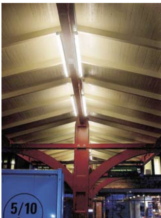
Centralstationen i Göteborg Hamm
