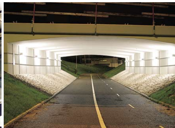
Gång- och cykeltunnel i Kortedala Marburg
