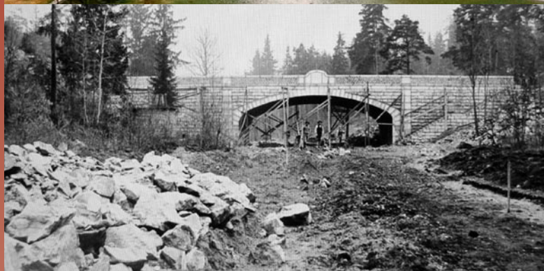
Östervägen, Solna Svart-vitt foto: Östervägen 1908 Armatur: SL Twin 35w (i tunnel), Luzern 21w (i broräcket) Beställare och idé: Anders Kordasz, Solna Stad Installatör och foto: Magnus Abrahamsson, Vattenfall
